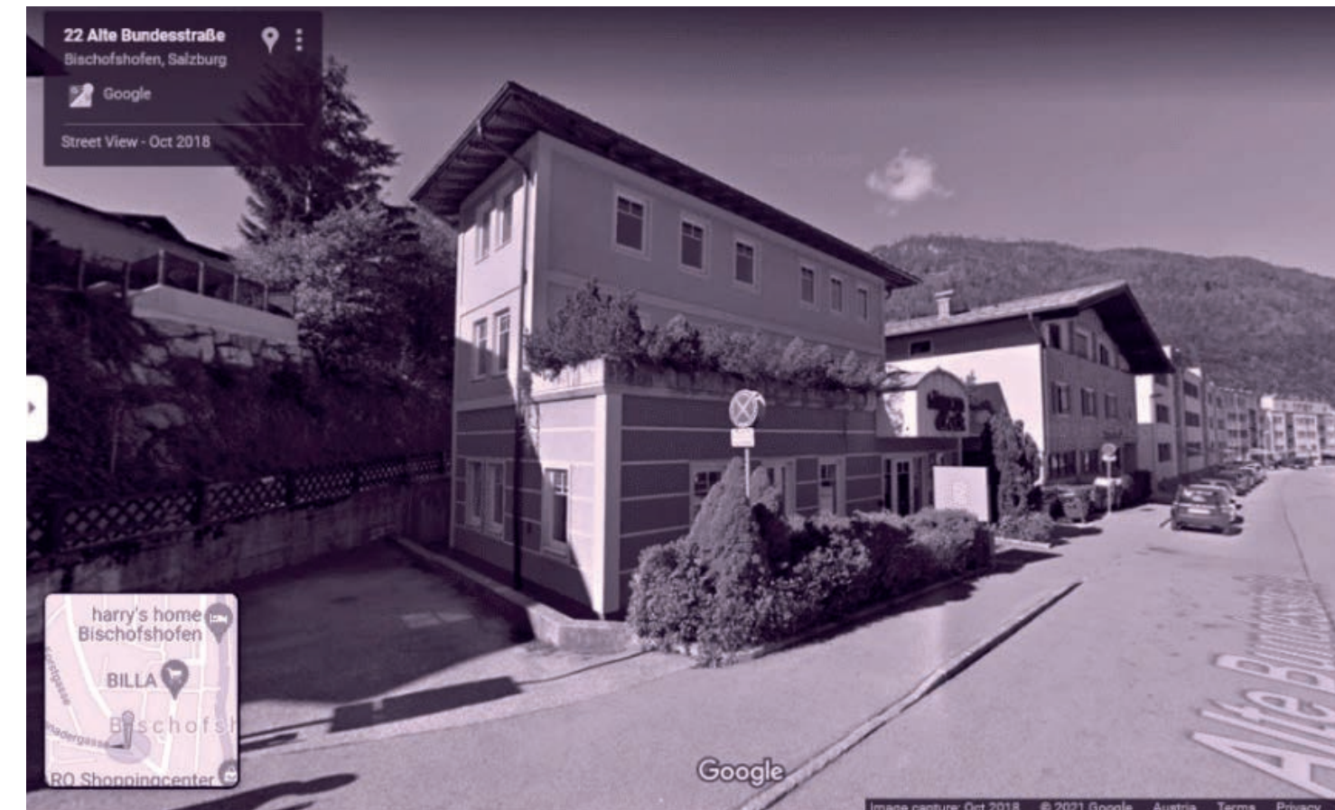
Im ehemaligen Gebäude der Druckerei in Bischofshofen sollen in Zukunft die Volkshochschule und flexibel nutzbare Coworking Spaces Platz finden. Quelle: Street View by Google Maps
