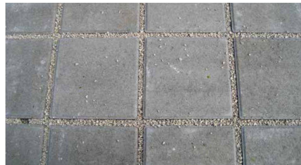
Atmungsaktive, versickerungsfähige Fugen entlasten die Kanalisation
