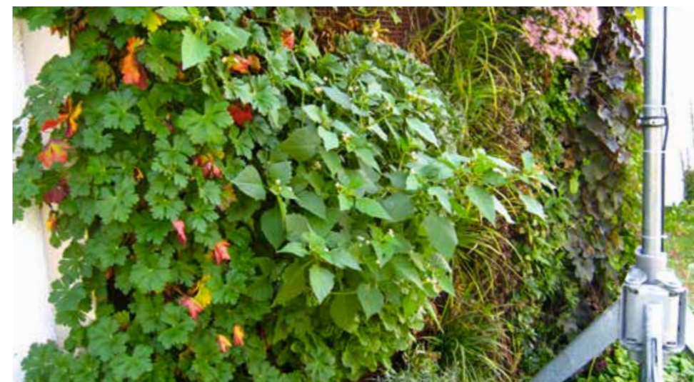
Fassadenbegrünung wirkt ausgleichend auf die Gebäudetemperaturen
